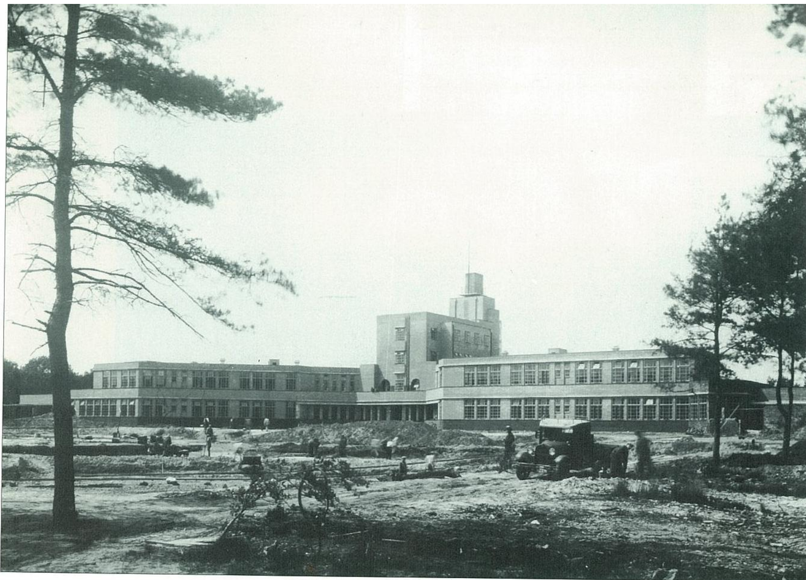
Een van de mooiste foto's uit de begintijd van het sanatorium.
