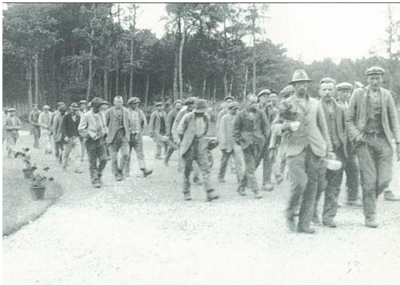
Patiënten op hun terugtocht van de eerste terreinwerkzaamheden voor het sanatorium. De grasperken van het gesloten gesticht werden blijkbaar nog met bloempotten verfraaid!
